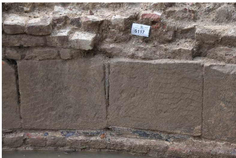
014. Detail van de waterlijst. Onder de blokken zijn leien zichtbaar. Hiermee zijn de blokken gesteld. De voorzijde van de blokken zelf is voorzien van een onregelmatig uitgevoerde frijnslag.
