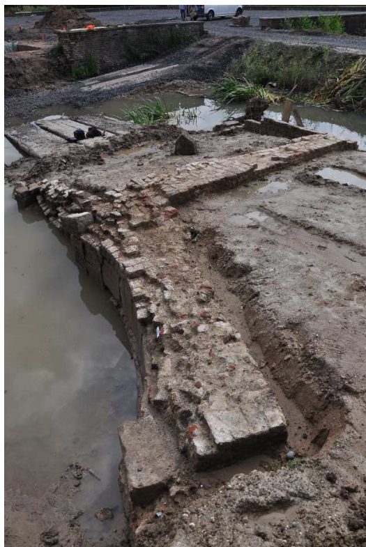
014. Detail van de waterlijst. Onder de blokken zijn leien zichtbaar. Hiermee zijn de blokken gesteld. De voorzijde van de blokken zelf is voorzien van een onregelmatig uitgevoerde frijnslag.
