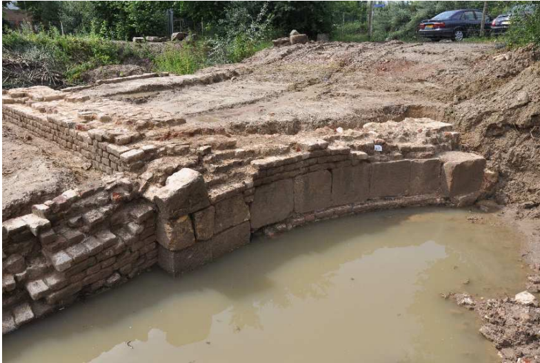
012. De oostzijde van het bruggenhoofd. Ter plaatse van de waterlijn zijn natuurstenen blokken toegepast, om inwatering van het metselwerk te voorkomen. Links is het onderste natuurstenen blok van de meest noordelijke boog zichtbaar. Ernaast het restant van de vulmuur die in de laatste fase de doorgang afsloot (zie ook de volgende afbeelding).
