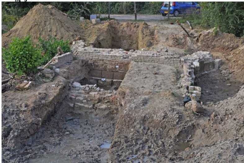
020. Het landhoofd gezien vanuit het zuiden. Op de voorgrond is het ten dele ontgraven metselwerk van de meest noordelijke brugpijler zichtbaar.
