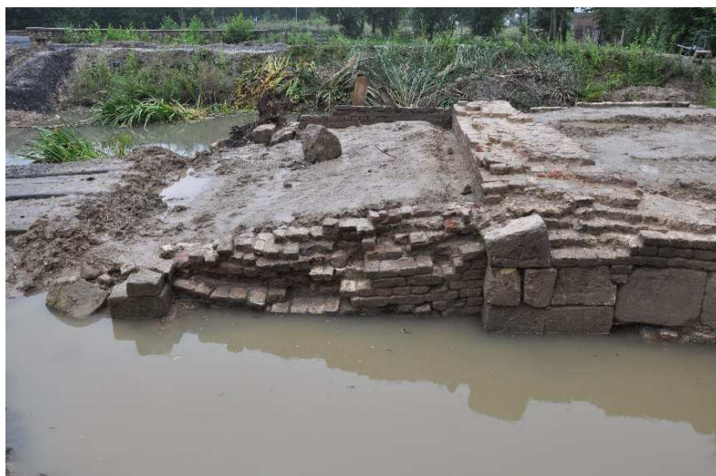
018. De dichtgezette doorgang van de brug gezien vanuit het oosten. Bij het bruggenhoofd is nog net de aanzet van de overwelling van de doorgang zichtbaar.
