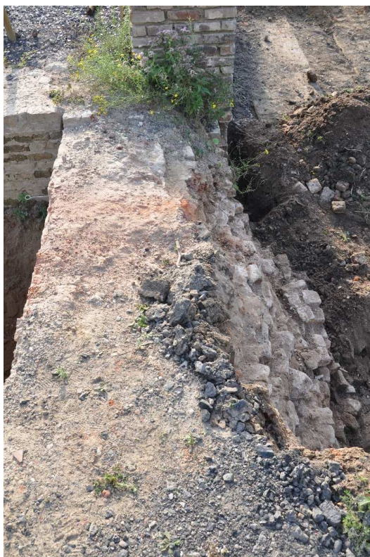
024. Bovenaanzicht van de noordgevel van de poorttoren. Hier is goed zichtbaar dat het metselwerk ter plaatse van de brug uitspringt ten opzichte van de noordgevel van de bouwhoeve. Tevens is hier goed zichtbaar dat de muur aan de noordzijde aanzienlijk minder goed bewaard is gebleven dan aan de zuidzijde. Links is nog een klein deel van de werkput binnen het poortgebouw zichtbaar.
