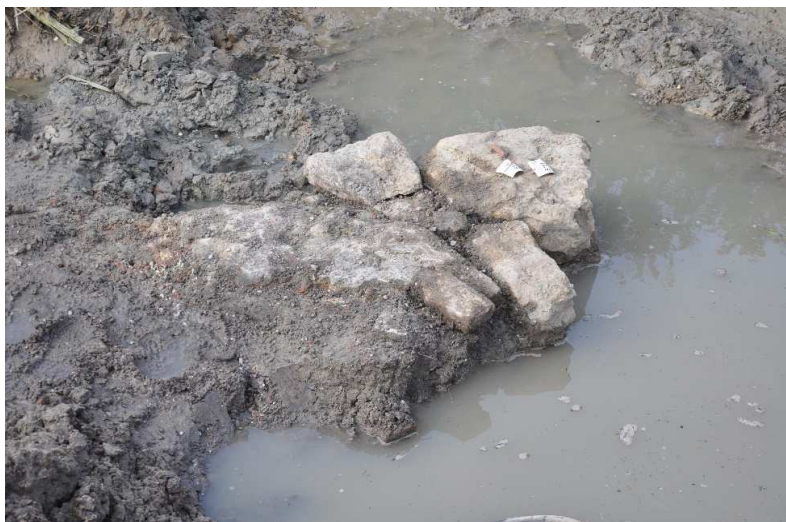
021. Het restant van de derde brugpijler (vanuit het noorden gerekend). Het betreft een fragment van de vlijlaag bestaande uit brokken natuursteen van verschillend formaat.
