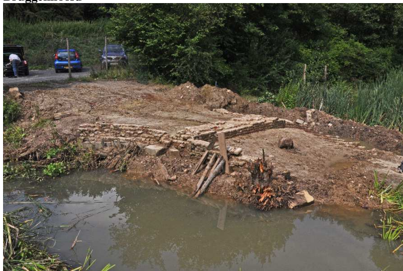
006. Overzicht van het noordelijke deel van de brug. Bij A is het originele metselwerk van het bruggenhoofd. B zijn de beide sluitmuren, die geplaatst zijn na het wegvallen van de overwelling. De beide muren verkeren in een slechte toestand, de voorste halve steen is vrijwel volledig verloren gegaan. Alleen bij C is nog een klein deel van het oorspronkelijke geveloppervlak bewaard gebleven. Bij D is nog net een klein deel van de eerste brugpijler zichtbaar.
