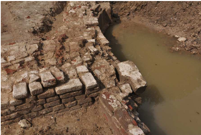
013. Detail van de aansluiting van de vulmuur op het bruggenhoofd aan de oostzijde van het bruggenhoofd. A is het oorspronkelijke (17de-eeuwse) metselwerk van het bruggenhoofd. Omdat het metselwerk aan deze zijde beter bewaard is gebleven dan aan de westzijde is hier - bij B - nog net de aanzet van de overwelling zichtbaar. Het bij C zichtbare metselwerk vervangt het metselwerk dat de aanzet vormde van de overwelling van de doorgang. Aangezien dit metselwerk van een rechte dagkant is voorzien, in tegen-
