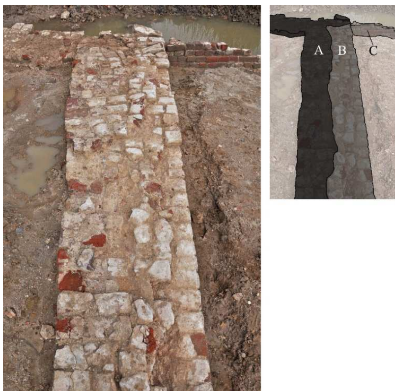
010. Dezelfde muur als in de vorige afbeelding, maar nu gezien in oostelijke richting. Bij A het oorspronkelijke metselwerk van het bruggenhoofd. Bij B het metselwerk dat na de sloop van de gewelven tot stand is gekomen en bij C het metselwerk behorend bij de vulmuur, die na het verwijderen van de gewelven onder de boog in de noordgevel van de brug zijn geplaatst.
