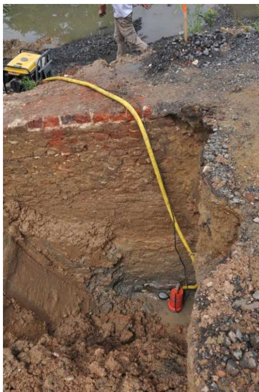
027. Detail van de fundering van de noordmuur. Geheel aan de onderzijde is bij de waterpomp nog net een houten balk zichtbaar, waarop het metselwerk is geplaatst. Vermoedelijk zijn onder deze plaat houten funderingspalen geplaatst.
